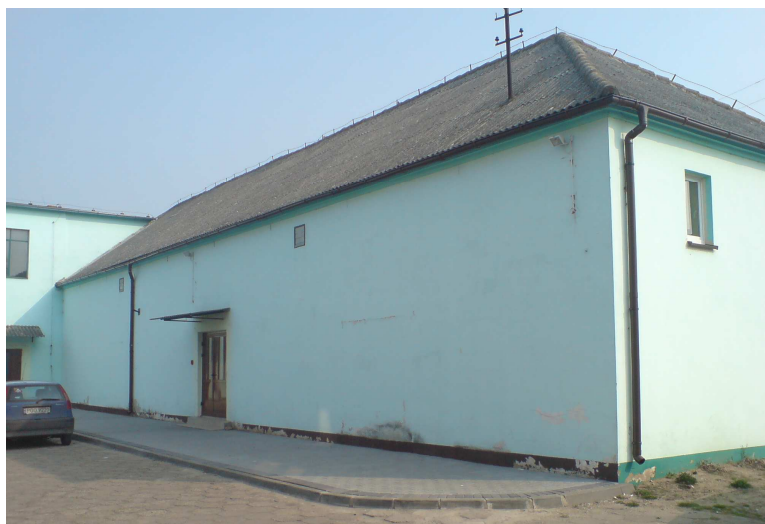
2.1 Budynek świetlicy wiejskiej w Wilkowie Polskim
